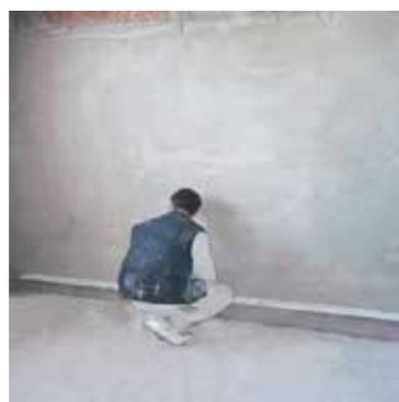
La première couche d'enduit, le **gobetis**, a une épaisseur de 15 à 20 mm. Elle est réalisée avec du sable grossier et elle est appliquée par jet à la truelle pour créer une superficie homogène et rugueuse. Le **dégrossi** s'étale sur une épaisseur de 10 à 12 mm; il est réalisé avec du sable de grains moyens lorsque le gobetis est suffisamment sec.
