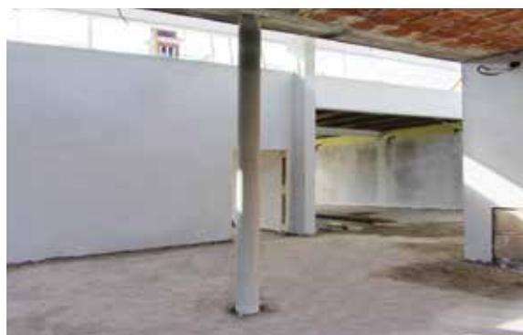
Enfin, l'**enduit de finition** a une épaisseur de 3 à 5 mm; il est réalisé avec du sable très fin et constitue la couche supérieure de finition de l'enduit. L'utilisation de la chaux dans la préparation de l'enduit est absolument fondamentale: elle permet la respiration de la maçonnerie et l'évaporation de l'humidité présente dans le mur.
