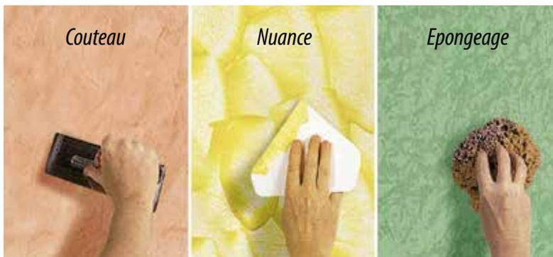
La **chaux grasse en pâte** est un revêtement pour l'intérieur fortement respirant permettant d'obtenir des finitions à la spatule brillantes et très décoratives, avec des teintes nuancées et une profondeur de trame variant en fonction des techniques d'application et du colorant ajouté.
