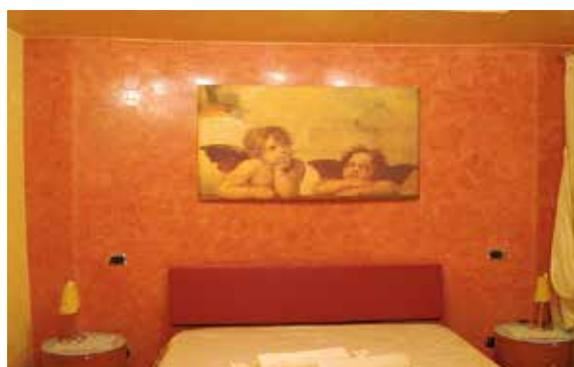
Sur un enduit sec et sans poussière, il faut tout d'abord étaler au moins deux couches de produit pour préparer le fond, puis appliquer de petites quantités avec une spatule métallique ou une taloche en acier inox, en superposant les couches pour obtenir l'effet tacheté ainsi que les transparences particulières et les estompages souhaités.
